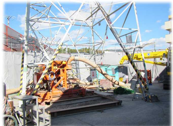
鉄塔下での施工
