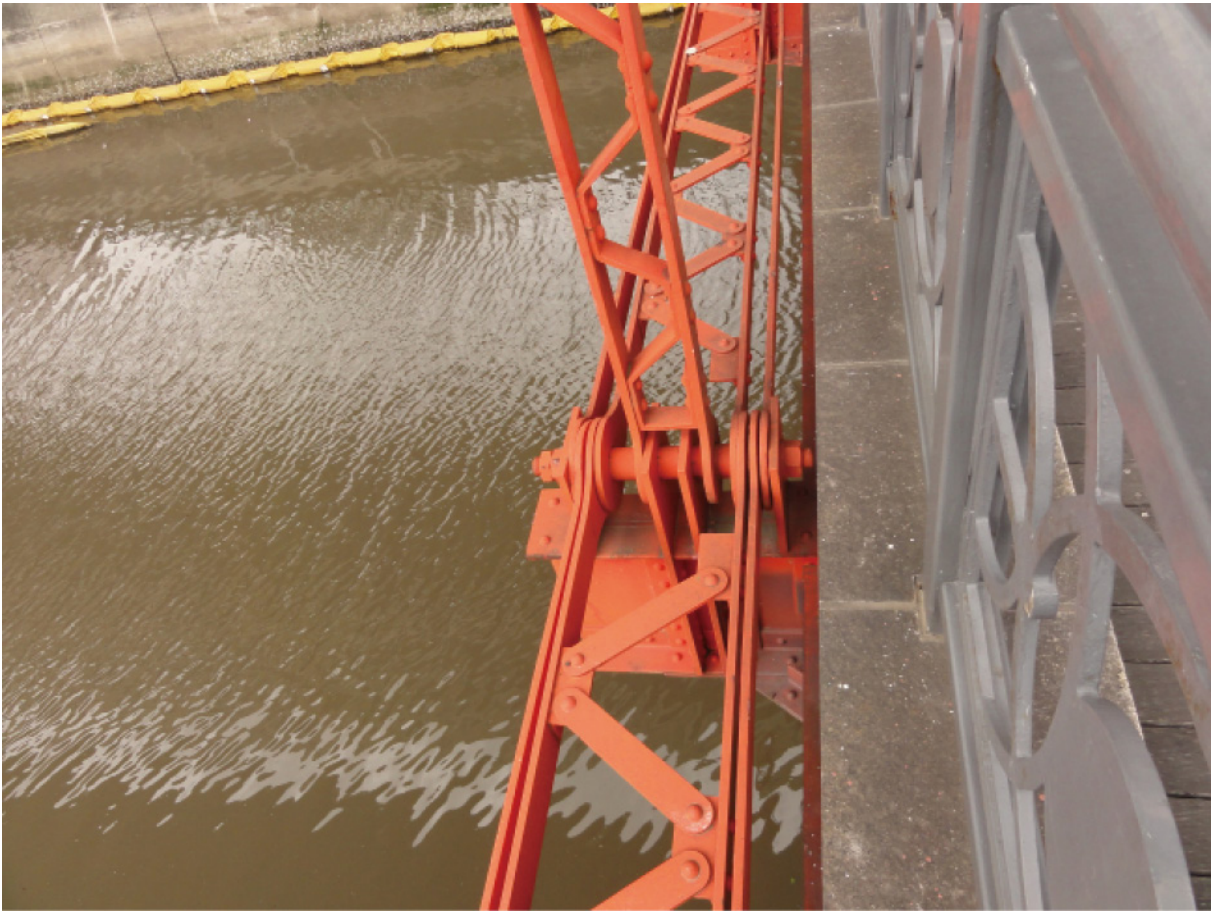
ピン結合部（浦舟水道橋）
