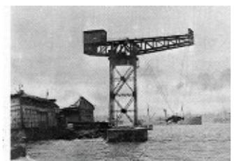
写真-2 関東大震災後の HC (50t 電気定置起重機)
