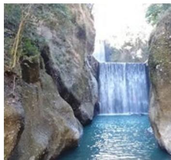
大平台堰堤、大平台上流堰堤
