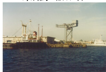
ハンマーヘッドクレーン (1982 年)
