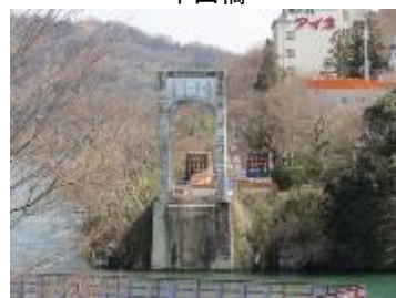
解体中の勝瀬橋の主塔(2010 年)
