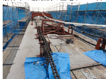
ハンマーヘッドクレーンの補修時の様子 (2011 年)
