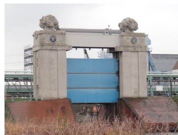
川崎河港水門
