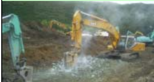
仮排水路掘削工(岩掘削)(6月22日～25日)
