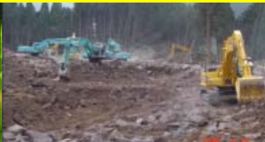
河道閉塞(天然ダム)対策工事着手(6月17日～)
