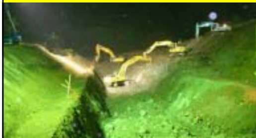
24時間態勢で仮排水路掘削工事実施(6月19日～27日)
