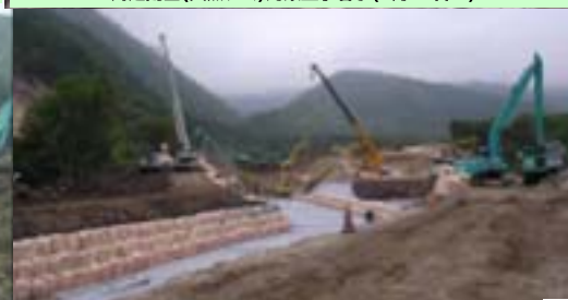
大型土嚢による護岸工(6月26日～27日)
