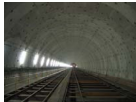
中央環状新宿線工事現場
