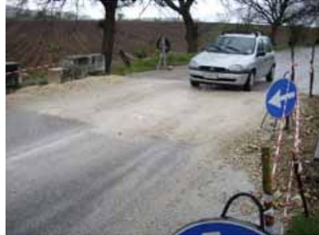
碎石による埋め戻しにより応急復旧
