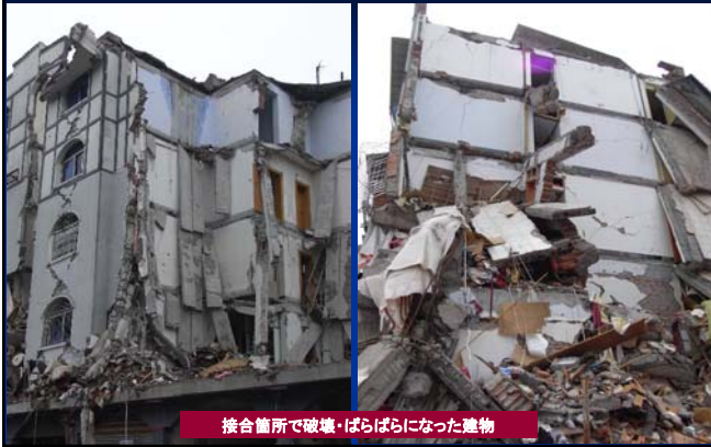
(2) 煉瓦造壁+Pcaスラブの被害： 接合箇所で破壊・分解
