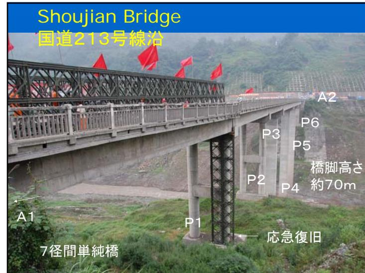
落下した桁の応急復旧
