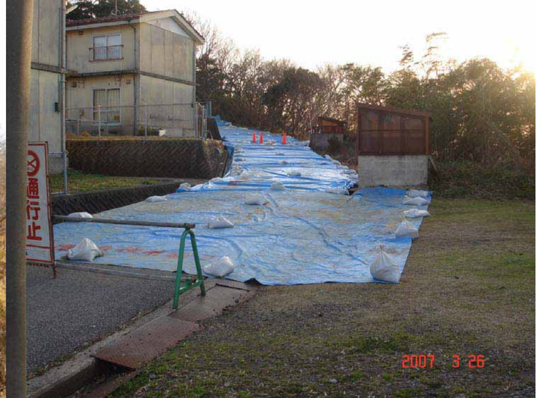
斜面法肩の市営住宅
