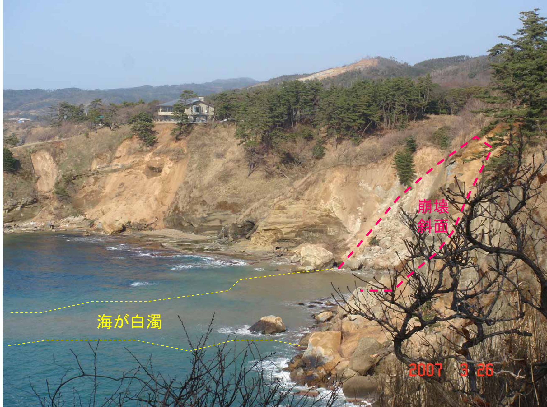
輪島市黒崎海岸斜面の崩壊
