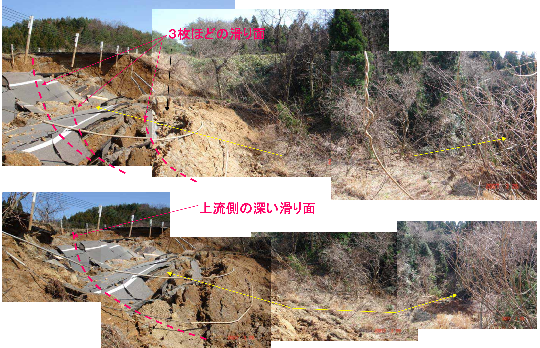
能登道路中島町谷内付近盛土崩壊(流動距離が長い)
