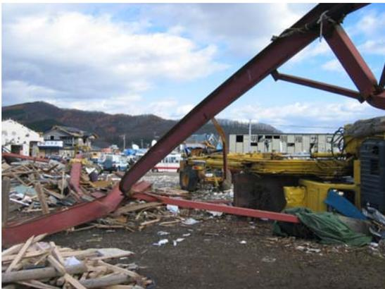
写真-3.31 全壊した倉庫の鉄骨架構[11]
