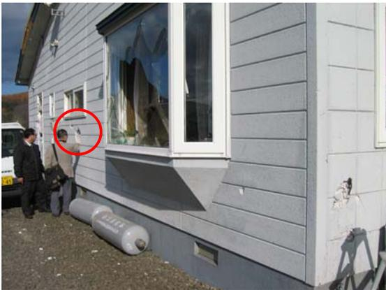
写真-3.47 住家壁面のプロパンガスボンベの衝突痕(丸内) [33]
