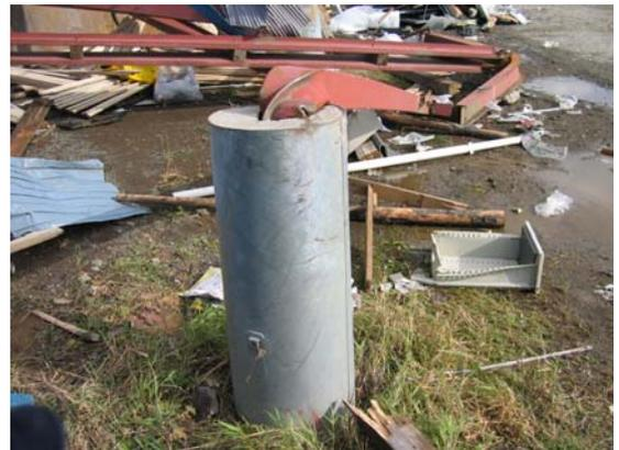
写真-3.32 全壊した倉庫の鉄骨架構の基礎[12]
