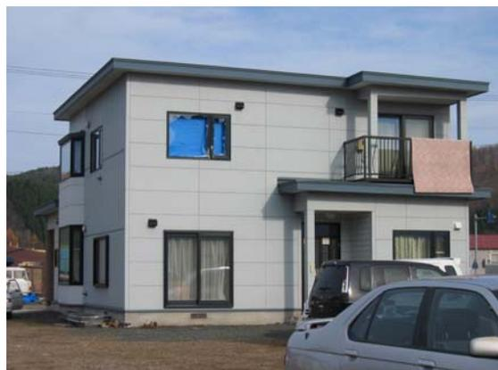
写真-3.41 窓ガラス、屋根葺き材に被害を受けながら骨組の被害はない建物（左[23]、右[24]）
