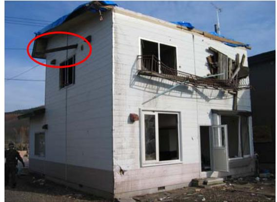
写真-3.46 住宅の壁面に刺さった木材の飛散物(丸内) [32]
