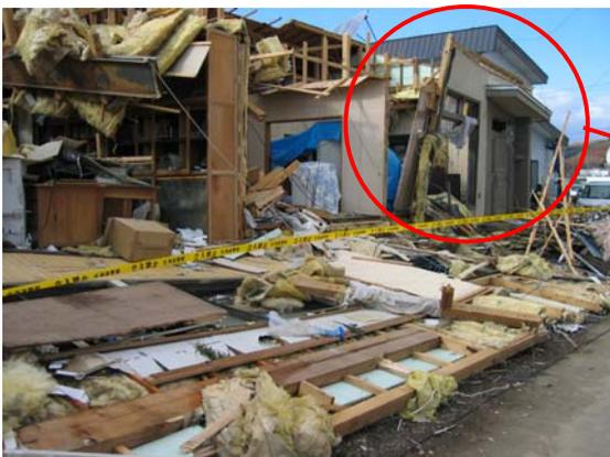
写真-3.37 全壊した建物（左：[17]）と隣接しながら被害が軽微な建物（右：[18]）
