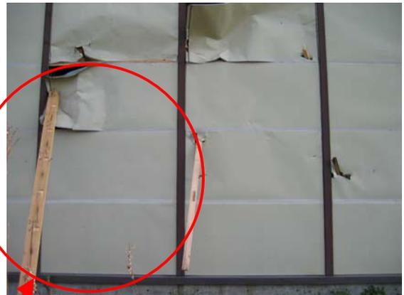
写真-3.48 倉庫の壁面に刺さった木材の飛散物(丸内) [34]
