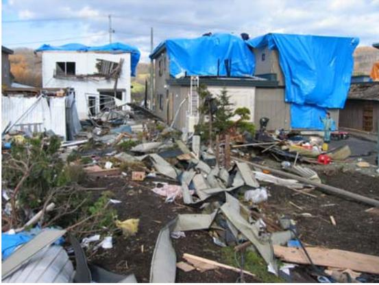
写真-3.38 散乱した飛散物と建物の壁面、屋根面の被害[19]
