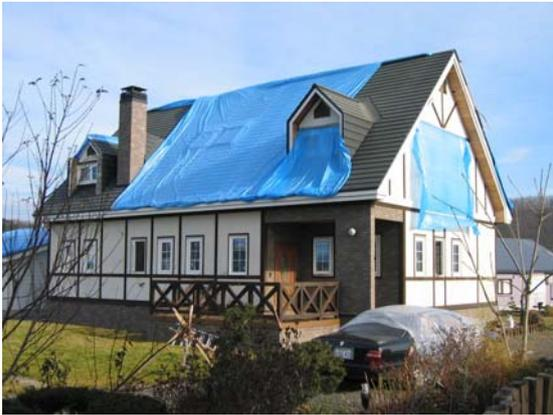
写真-3.40 窓ガラス、屋根葺き材に被害を受けながら骨組の被害はない建物（左[21]、右[22]）
