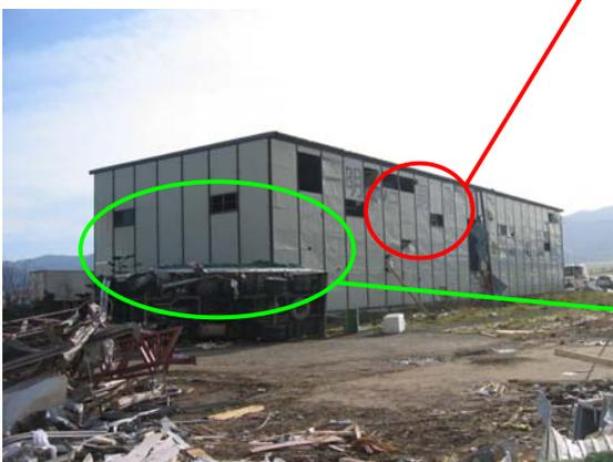
写真-3.49 倉庫の壁面に刺さった木材の飛散物(右丸内)と転倒した大型トラック(左丸内) [35]
