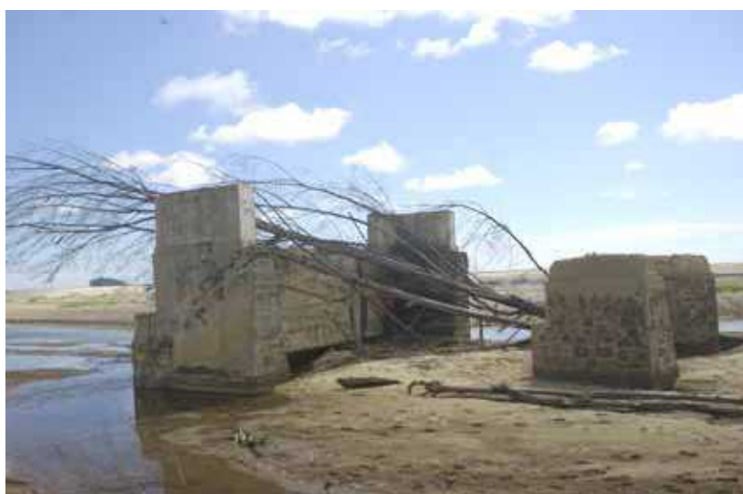
▲橋梁の桁は流失し、取り付け道路も完全に流出している。砂浜に取り残されているように見えるが、津波前と比べて周辺の地形全体が大きく変化している。
