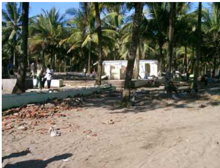
写真-1 ウィダラバユン ウェタンの海浜公園施設の被災 (7° 42'S, 109° 16'E)
