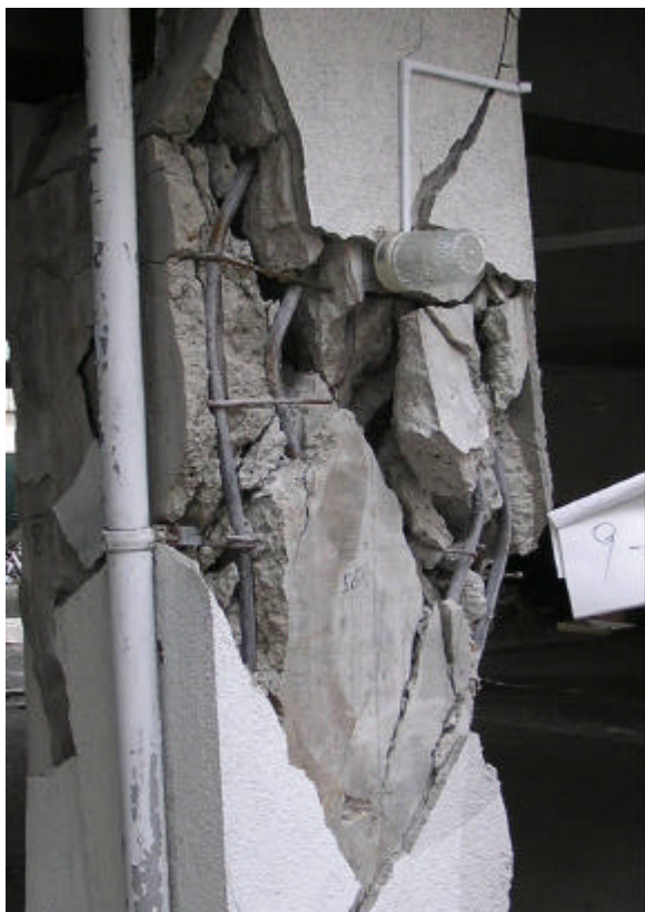
写真 - 1 柱のせん断損傷
