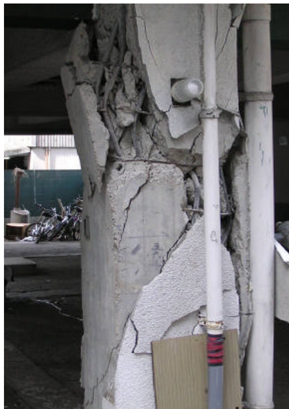
写真 - 1 柱のせん断損傷
