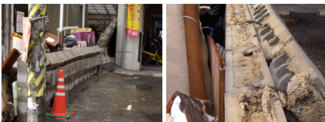
(a)ブロック塀倒壊の様子
