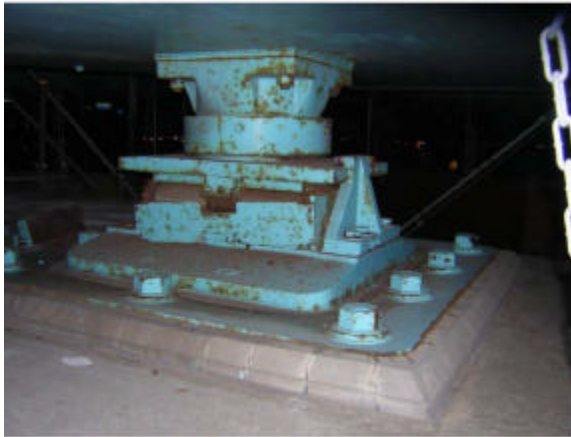
(b)サイドブロック損傷（下流）
