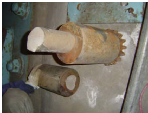
(c)ローラー損傷
