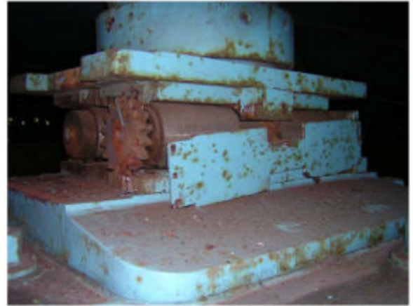
(b)サイドブロック損傷（下流）
