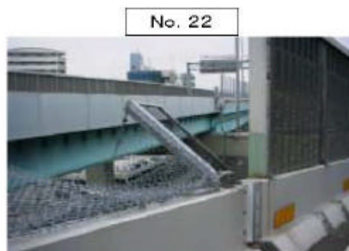
(g) 落下防止用フェンスの取付部の損傷
