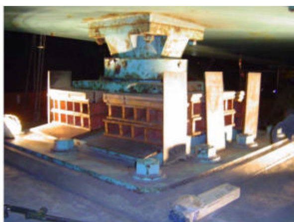
(b)サイドブロック仮復旧状況（下流）
