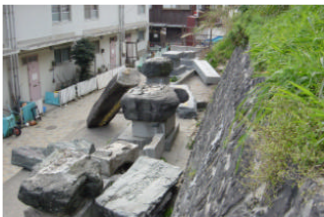
写真 3.2.21 小鷹神社横の石礎の倒壊
