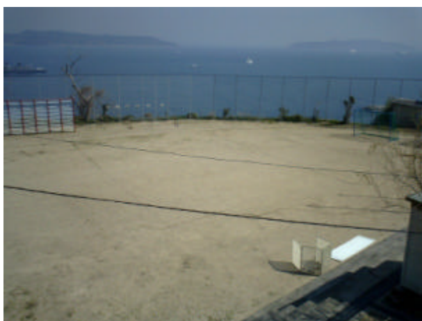
写真 3.2.16 玄界小学校のグラウンドのひび割れ
