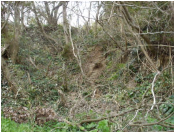
写真 3.2.26 玄界中学校裏の斜面崩壊
