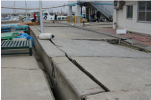
写真 3.2.6 岸壁の沈下
