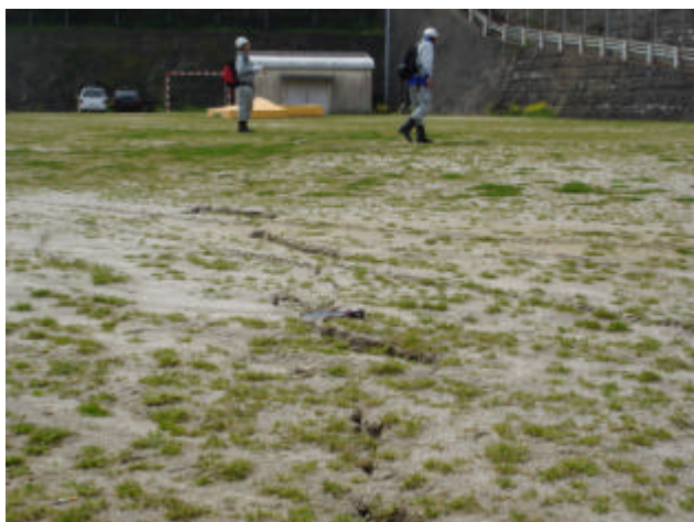
写真 3.2.19 玄界中学校のグラウンド亀裂
