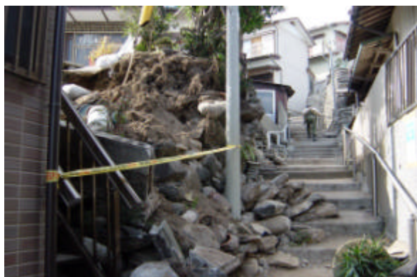
写真 3.2.12 擁壁の崩壊
