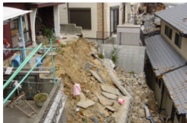
写真 3.2.9 擁壁・盛土の崩壊と家屋被災
