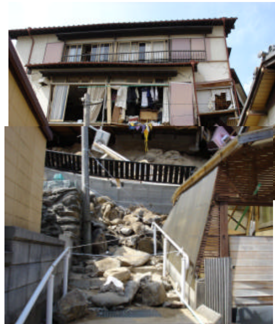
写真 3.2.9 擁壁・盛土の崩壊と家屋被災
