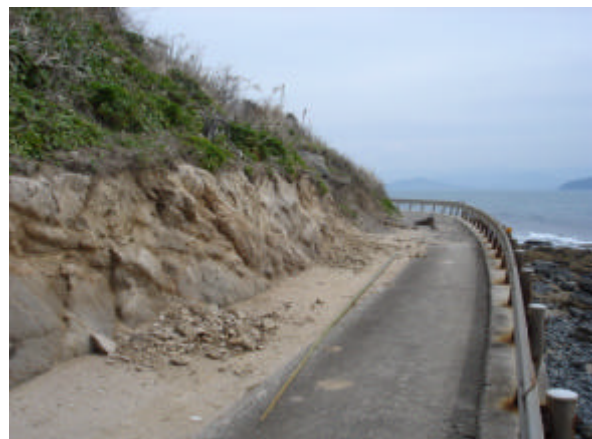
写真 3.2.3 道路に対する土砂流出
