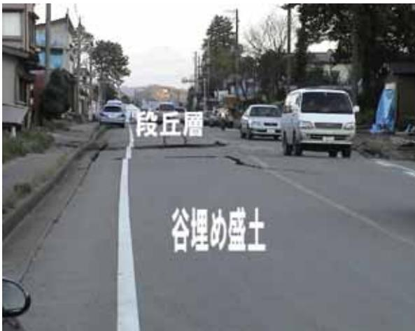
道路の谷埋め部は軒並み沈下変状している
