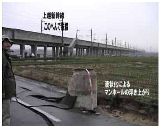
上越新幹線脱線現場付近の液状化
