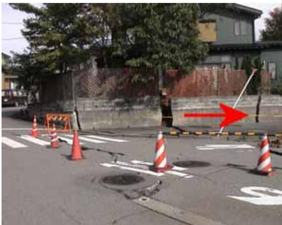
盛土が斜面下方に移動し、大きな開口亀裂を発生させている。
