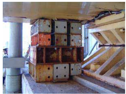
写真 3 サンドルによる仮受け
