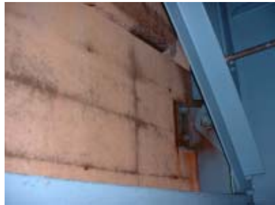
パラペット上部のコンクリート隔離
