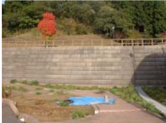
道の駅に設置されているブロック積み擁壁
