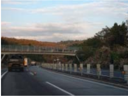
被災したπ型ラーメン橋
