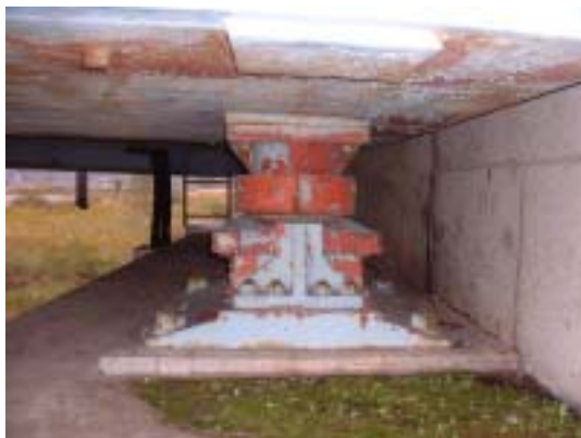
越の大橋の支承（東京側橋台）
