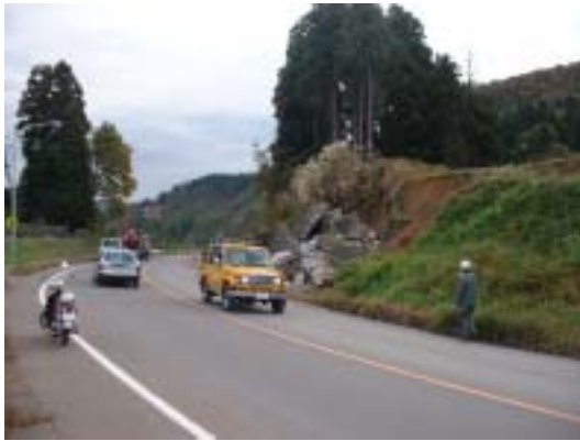
崩壊箇所の全景
