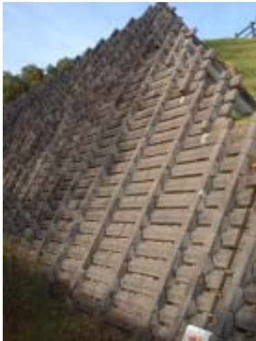
道の駅に設置されている井桁組み擁壁
