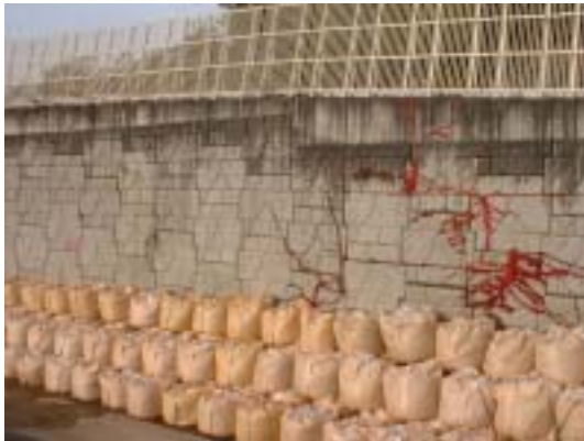
上り線ランプに設置されているテールアルメ
