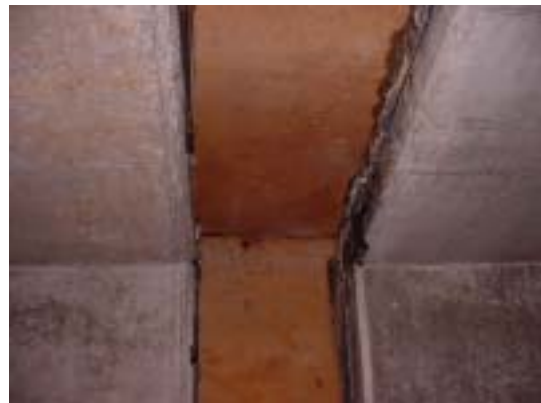
小千谷 2 カルバート（開口部の鉄板）
