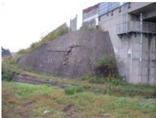
ブロック積擁壁（下り車線側）
