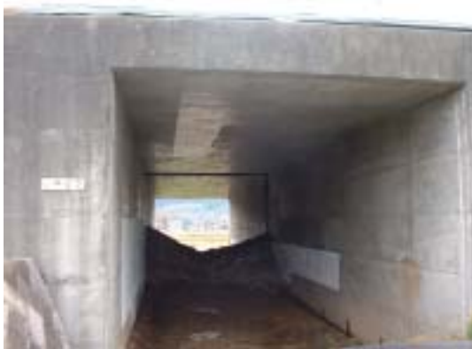
小千谷 2 カルバート（下り車線側から）
