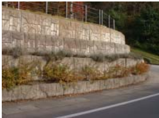
道の駅に設置されている箱形擁壁
