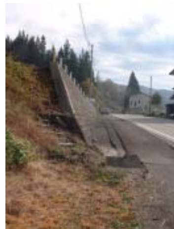
道路部に面したブロック積み擁壁
