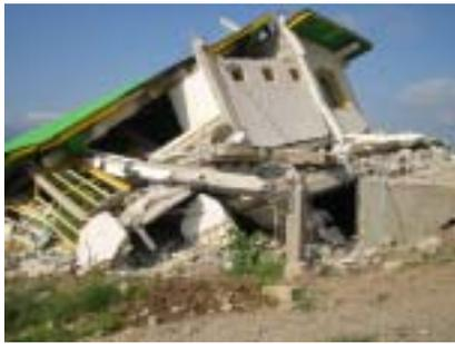
写真 6 2階建 RC 建物の崩壊
