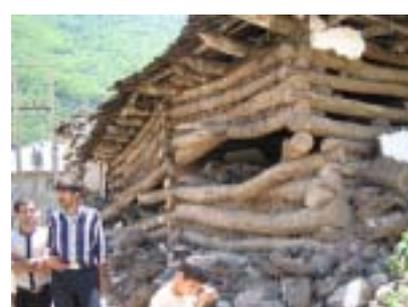
写真 5 丸太建物の破損
