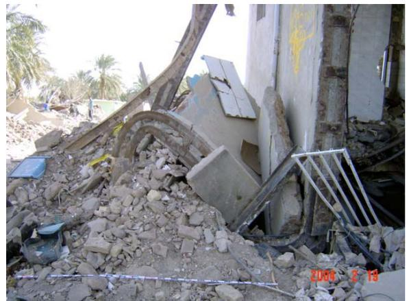
写真-2 鉄骨造建屋の西方 (写真右方) への倒壊
