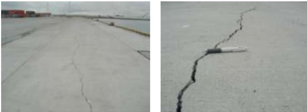
写真-2 釧路西港第四埠頭-14m 岸壁被害状況
