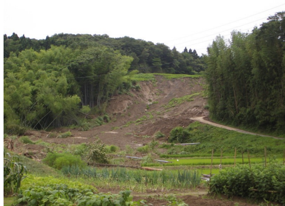
写真 7.5 河南町北村西猿田地区の斜面崩壊
