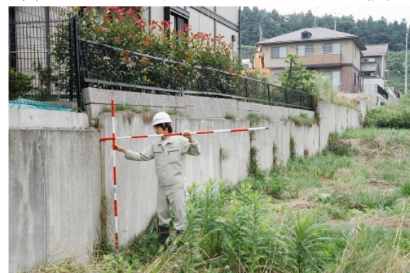
写真 7.4 矢本町緑ヶ丘団地：L型擁壁の被害
