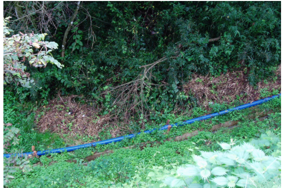
写真9.1 船越地区配水管の仮復旧
