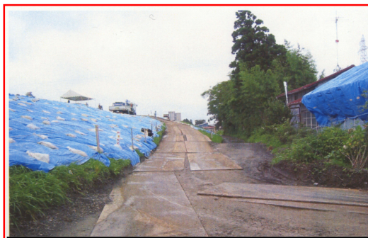
写真 6.8 法尻付近の樹木の傾斜
