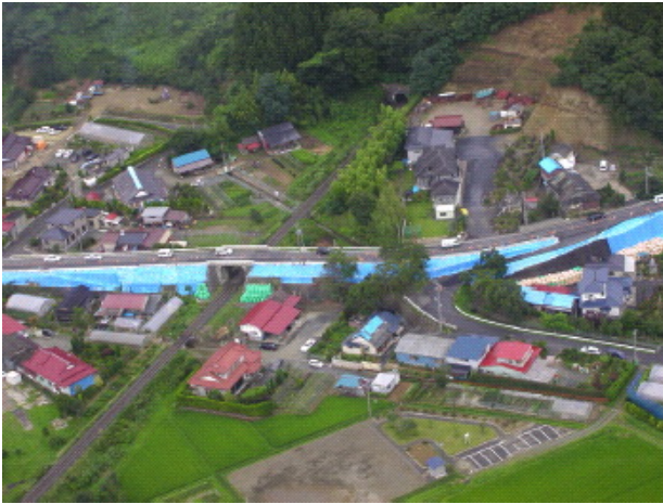
写真 5.3 国道 108 号河南町前谷地の被災地 1)
