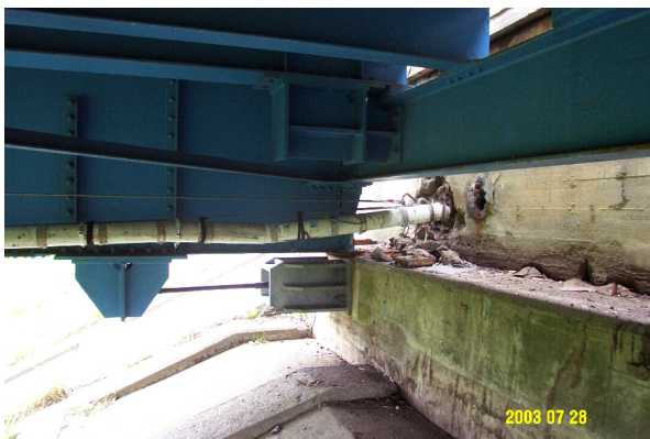
写真 5.1 小野橋南側橋台の桁掛かり
