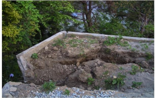
写真 7.2 コンクリート擁壁の被害
