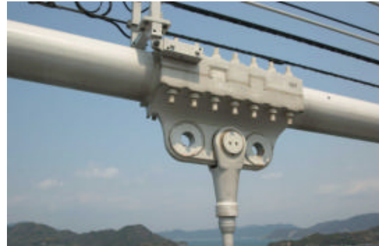
写真-4 メインケーブルの取付部
