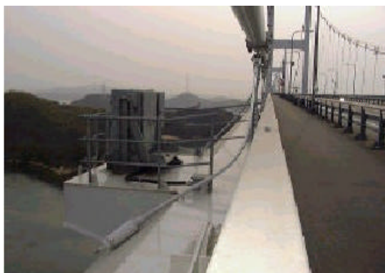
写真-2 地震直後のセンターステイの状況(*)
