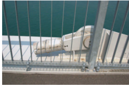
写真-3 桁側のソケット
