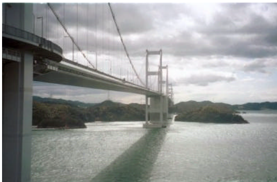
写真-1 来島海峡第一大橋
