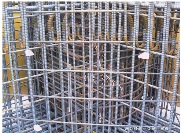
解説 図 7.3.8 部材接合部の密な配筋状況
