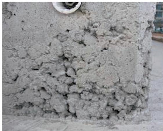
解説 図 7.3.11 柱部下端のジャンカの発生状況
