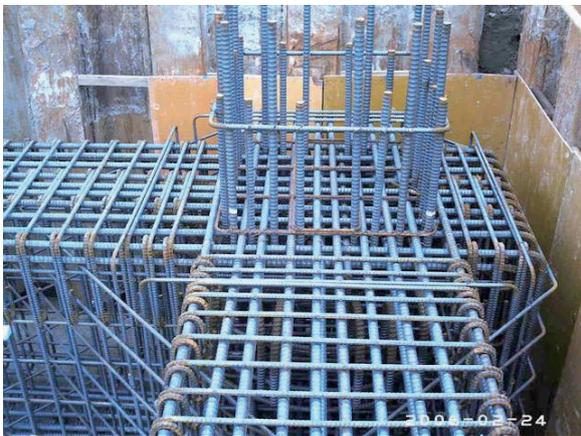
解説 図 7.3.7 地中ばりと柱部の鉄筋の取合い
