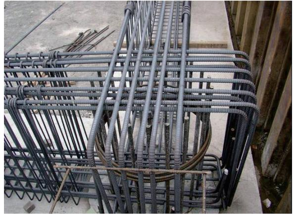
解説 図 7.3.6 杭と地中ばりの鉄筋の取合い
