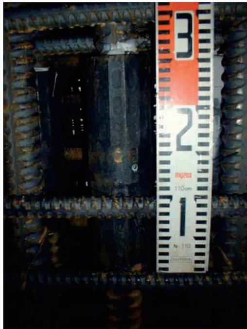
解説 図 7.3.2 D51鉄筋の機械式継手
