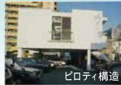
浸水の恐れのある地域において、浸水被害を軽減するため、住宅をピロティ構造にするなどの工夫
