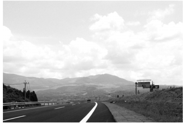
写真-6 加久藤トンネル進出時の風景（宮崎県えびの市）
