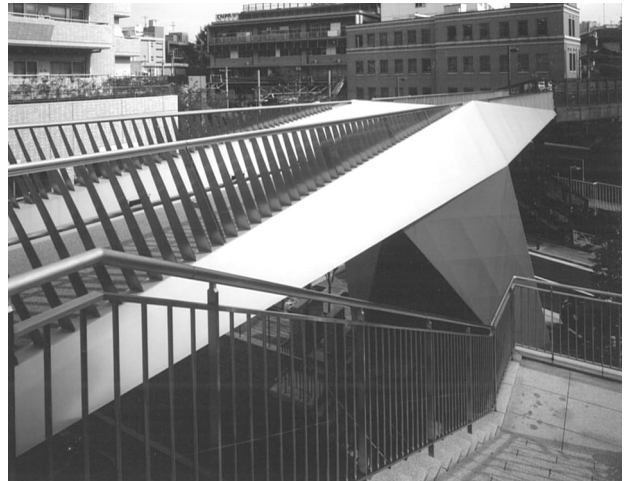
写真-10 第2人道橋 アドレス側から跨線橋側を見る
