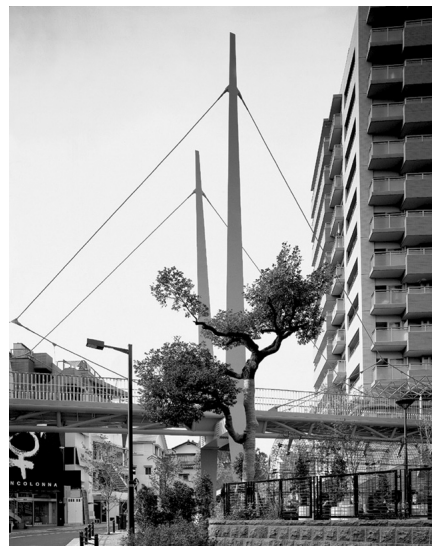
写真-5 第1人道橋 代官山公園側から主塔を見る
