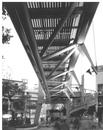
写真-6 第1人道橋 桁下から見上げた状況
