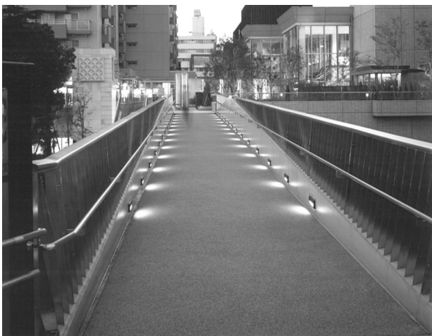
写真-9 第2人道橋 夕方の橋上空間 ライトアップ
