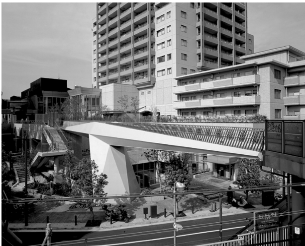
写真-8 第2人道橋 跨線橋側からアドレス側を見る
