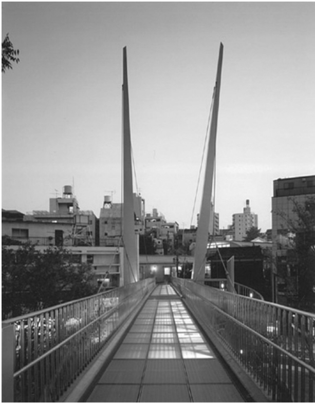
写真-7 第1人道橋 夕方の橋上空間 ライトアップ
