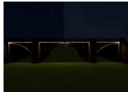
図-9 (2)-d RCアーチ橋(開腹)の例
