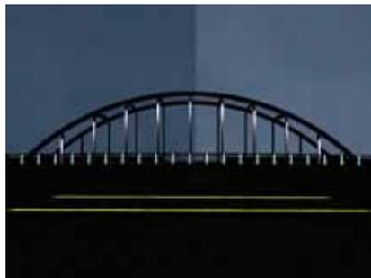
図-8 (2)-b 下路鋼アーチ橋の例
