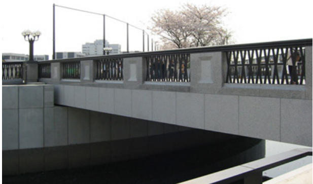
写真 10 橋の側景観 を用いている。
