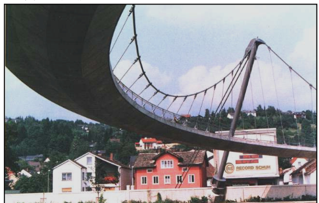
写真2 ケールハイム歩道橋
