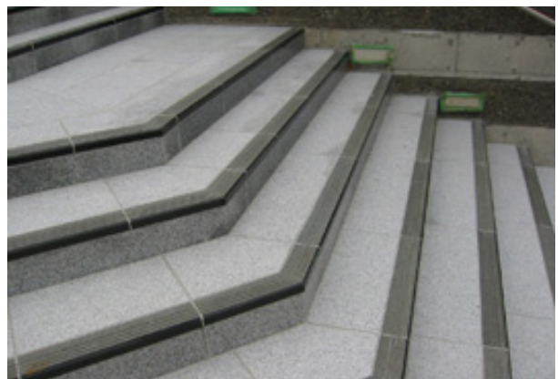
写真6 階段段鼻処理
