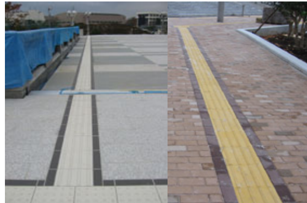
写真5 点字ブロック(左:橋上、右橋詰)
