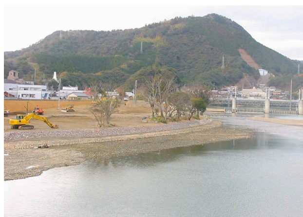
図-10 施工中のスロープ(河畔林の奥)
