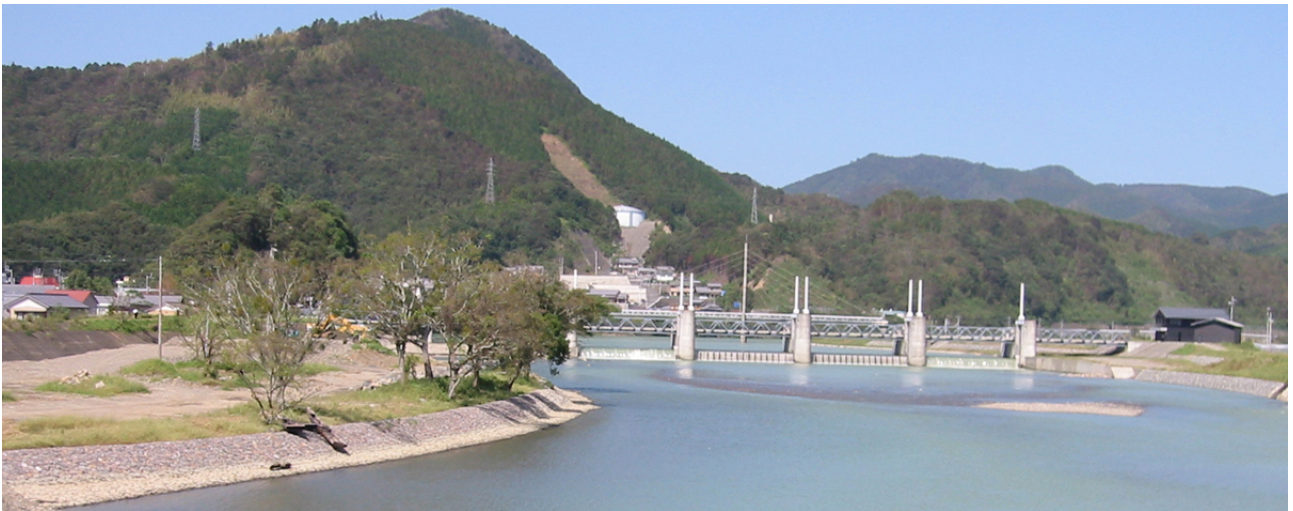
図-15 下流側から見た河川公園(施工中)と河戸堰の風景
