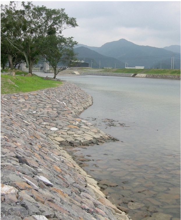
図-13 完成した No.64 付近の護岸. カヌー乗り場として使えるスロープを介して、No.60～64 区間の護岸と No.64～67 区間の護岸を切り替えている. 写真は満潮時.
