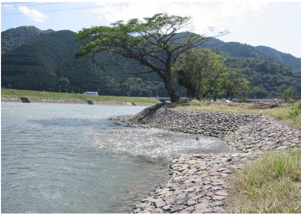
図-12 竣工した護岸 (No.67 付近). 手前が No.67～70 区間の三割勾配の護岸で、奥が河畔林まわりの一割五分勾配の護岸.
