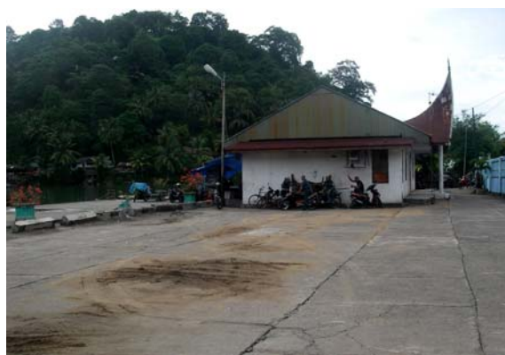
(d) lateral spreading at Padang Port
