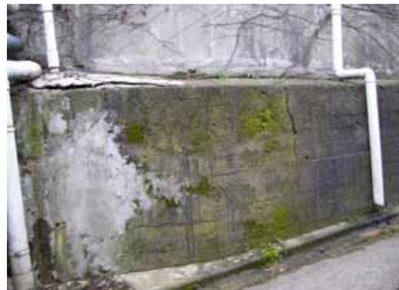
写真10.2-2 現場打ちL型擁壁：コーナー部
