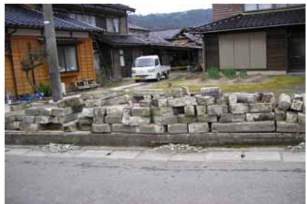
写真10.2-8 ブロック塀の倒壊
