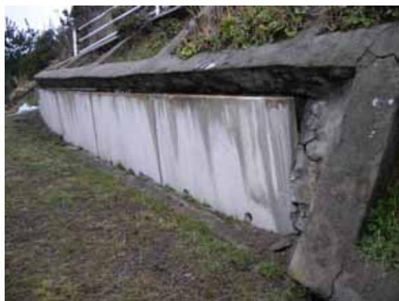
写真10.5.1-3 フリーフレーム枠のずれ
