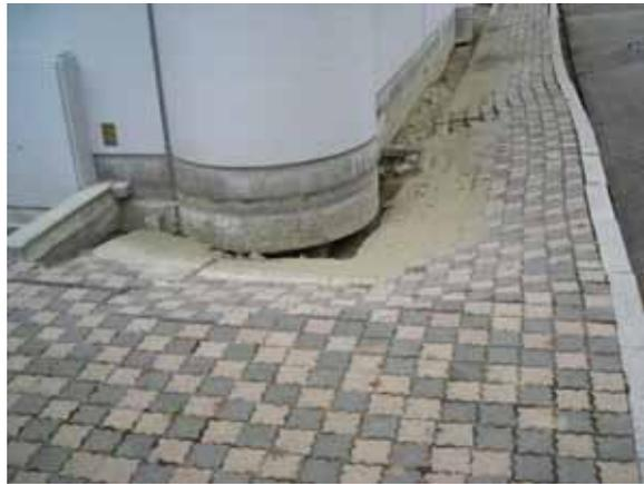
場内舗装の沈下
