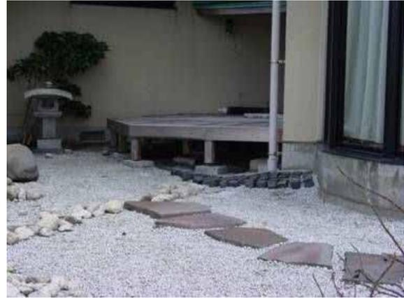
写真 3.6-2 建物周辺地盤の沈下
