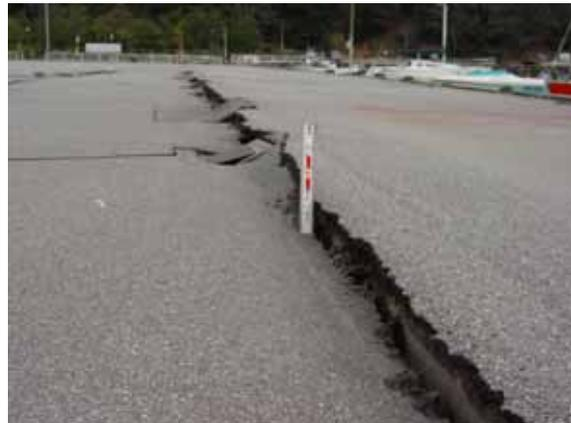
写真 3.3.3-1 エプロン部の沈下
