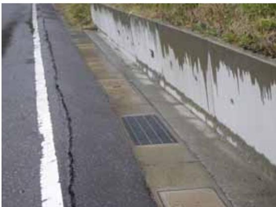
写真10.2-7 鹿磯港：プレキャストL型擁壁の傾斜
