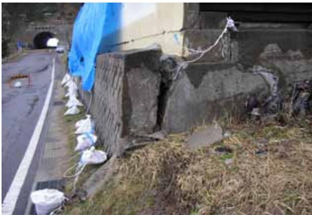
写真10.2-5 鹿磯港：練石積擁壁の倒壊
