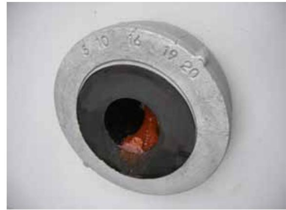
写真10.5.1-5 アンカー工の頭部の抜け出し
