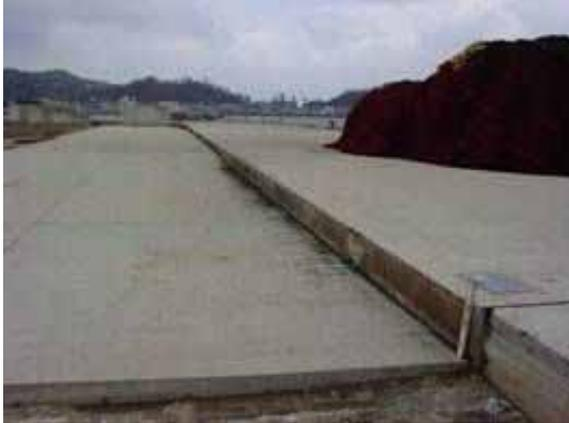
写真 3.3.2-5 エプロン部の沈下
