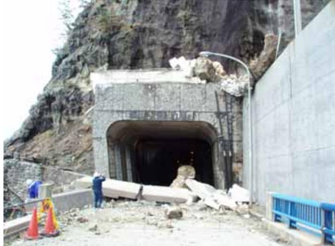
写真 4.1.5-2 崩落岩塊の一部による洞門の被災状況
