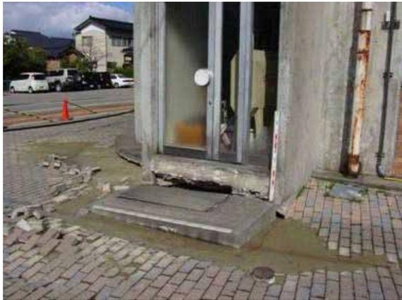
写真 3.6-1 建物周辺地盤の沈下
