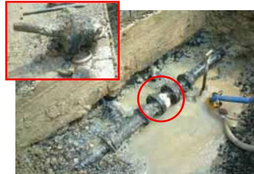
写真 9.1.4-4 仕切弁本体部の破損
