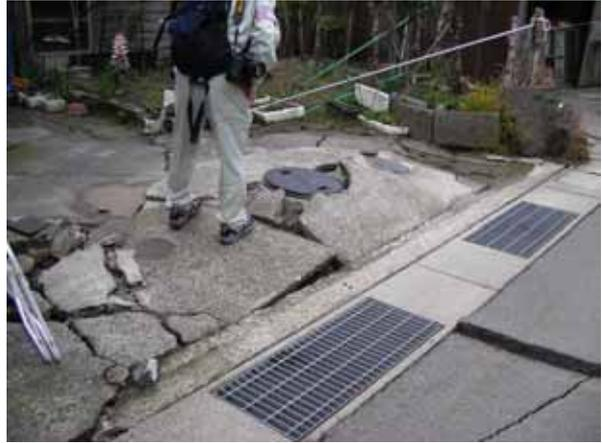
写真10.3.1-1 液状化による合併浄化層の隆起
