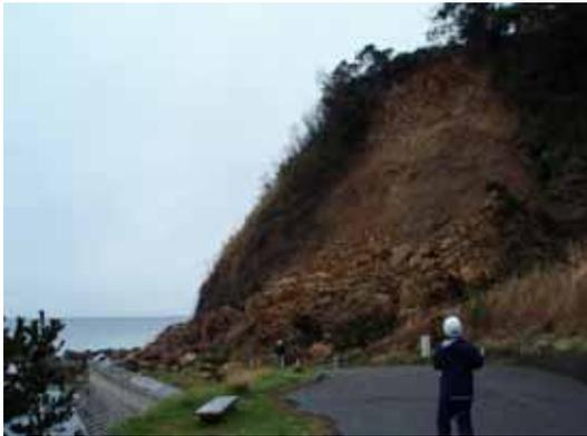
写真 4.1.4-1 海食崖の崩壊(S-9 地点)
