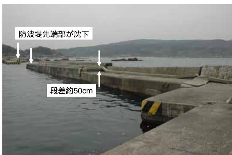
写真 7.4-2 鹿磯漁港 防波堤先端部の沈下
