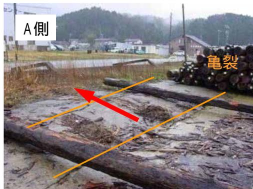
写真 3.7-3 護岸背後地盤の亀裂と噴砂
