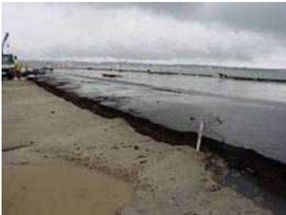
写真 3.3.4-1 エプロン部の沈下(地点 )
