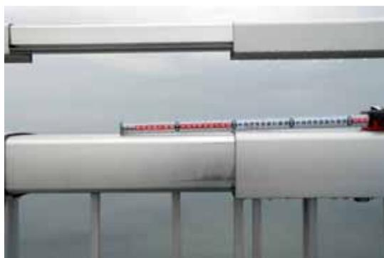
写真 1.4.2-3 中能登農道橋に見られる橋軸方向（東西方向）の振動痕
