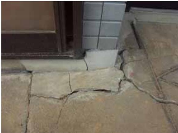
写真 11-15 建物基礎被害例(輪島市門前町道下)
