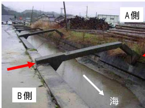
写真 3.7-1 支え構造の曲げ破壊
