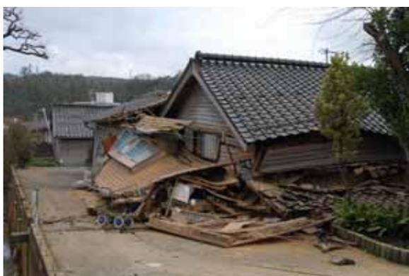
写真 11-10 建物倒壊例（輪島市門前町道下）
