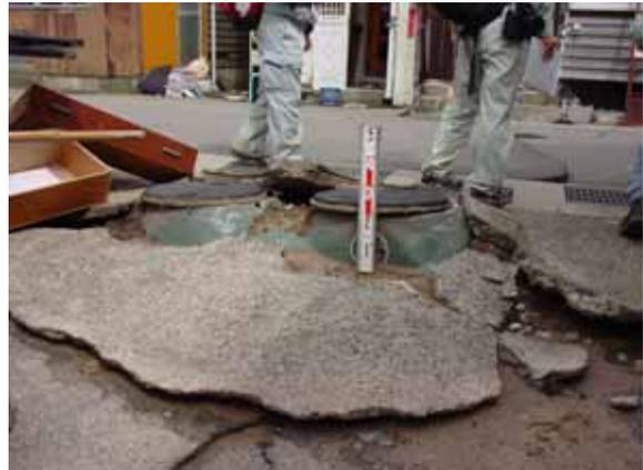
写真 3.4-2 浄化槽の浮上
