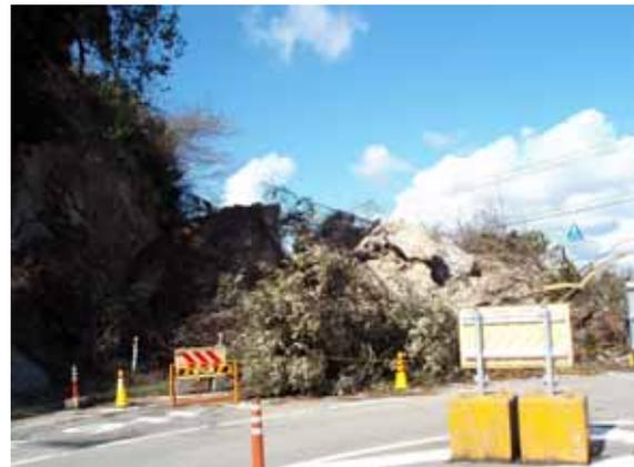
写真4.1.1-2 横から見た尾根状部の転倒崩壊
