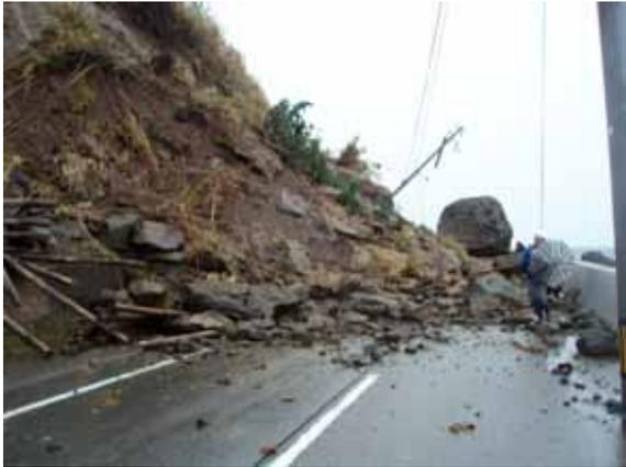
写真 4.1.3-1 表層崩壊と落石(S-14 地点)
