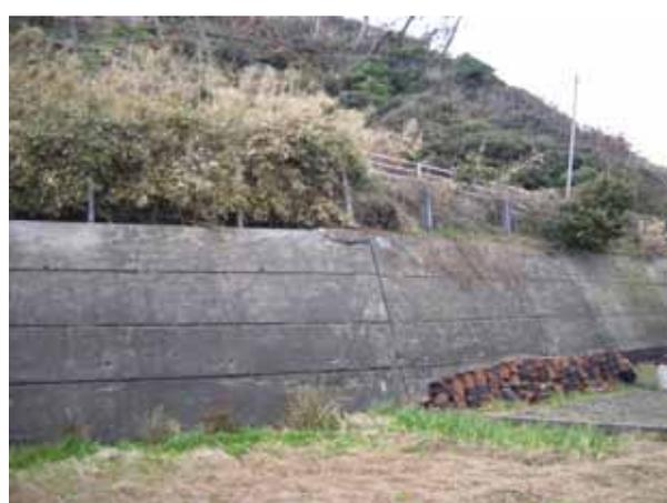
写真10.5.1-2 擁壁部の傾斜・クラック
