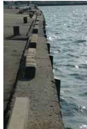
写真 7.3-2 七尾港矢田新町地区 岸壁法線のずれ
