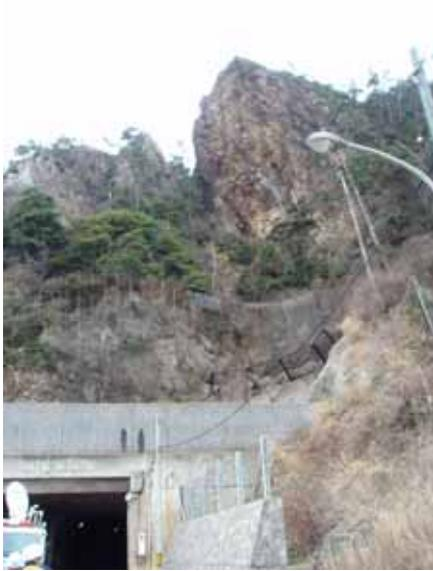
写真 4.1.5-1 洞門の右上の露岩部が崩壊発生位置
