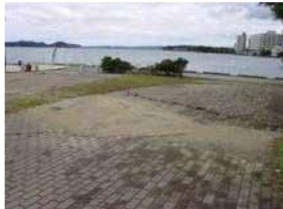
写真 3.3.4-4 インターロッキングの沈下(地点 )
