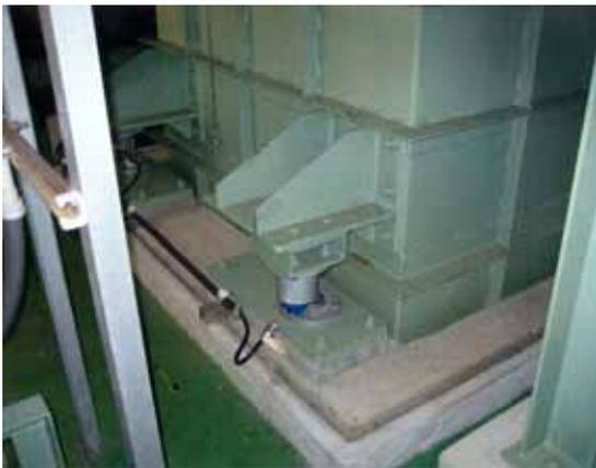
汚泥棟ロードセル基礎のずれ
