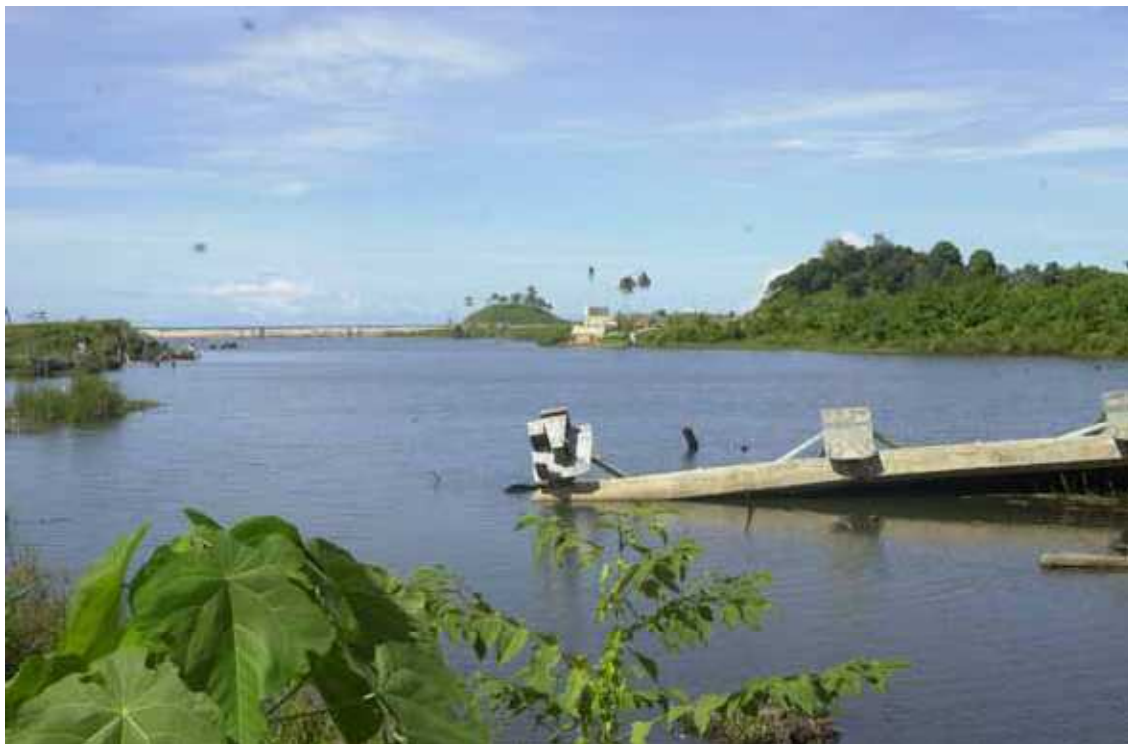
▲トラス橋の上部工が約 300m 飛ばされている。向こう側が海岸線で中央付近のやしの木手前に見えるのが橋台。
