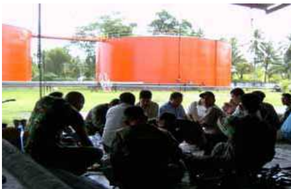
写真-6 被災前のパームオイルタンク (4° 12' N, 96° 2' E)
