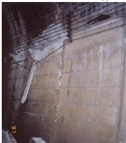
(b) 天納トンネル内部の被害状況（左および上の写真）
