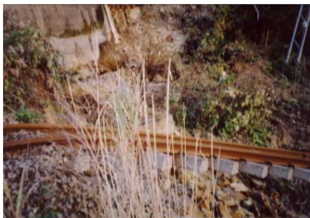
(a) 斜面崩壊で吊り下がったレール
