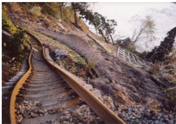
(a) 斜面崩壊で吊り下がったレール
