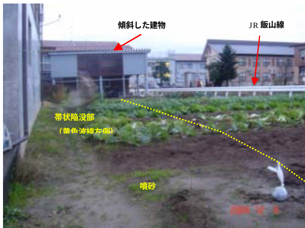
図 7.8 帯状陥没部を跨ぐ傾斜した建物と陥没部内噴砂（十日町市美雪町 3 丁目）
