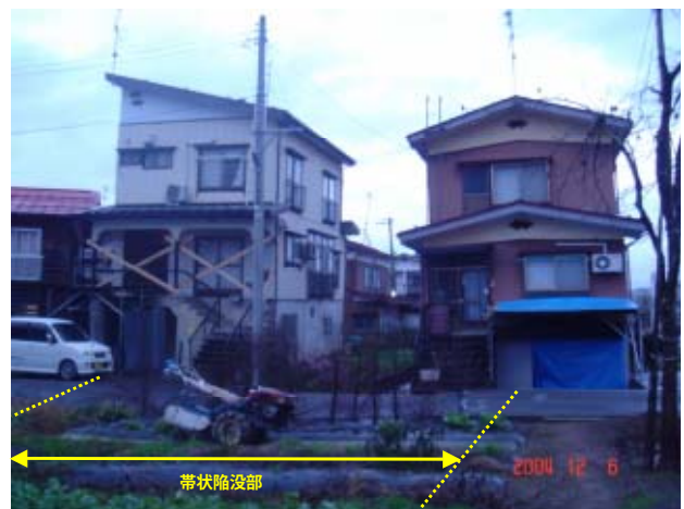
図 7.9 帯状陥没部を跨ぎ向かい合って傾斜した 2 棟の家屋（十日町市美雪町 2 丁目）
