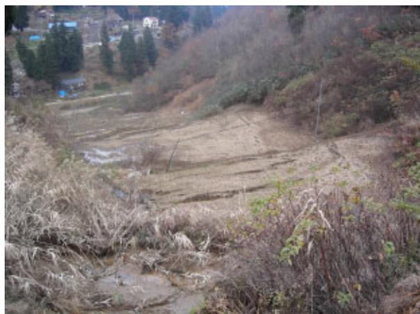
図15 1次谷の谷底の切り盛りで造成された水田の崩壊（山古志村池谷の南：上流から下流を望む）。切土部は破壊していないが、その前面の盛土部はすべて滑落している。
