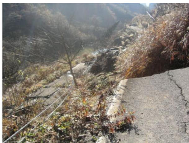
図10 最も不安定な柱目盤斜面の基部(古い地すべり堆末端の可能性もある)の地すべり。切取で建設された道路地盤は粉碎されずにブロックになって左下方に滑落した。
