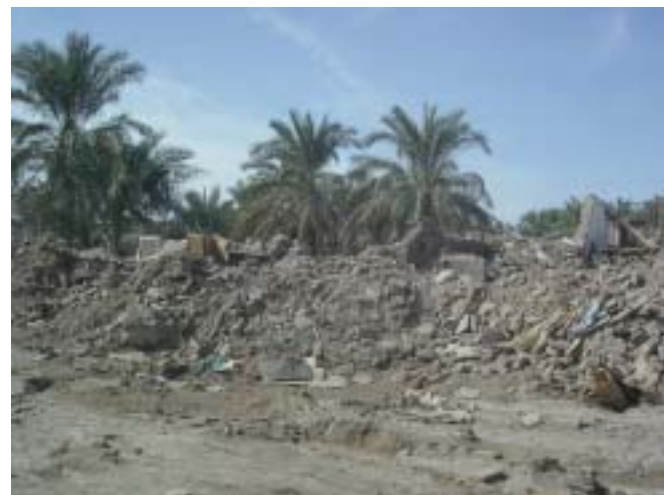
図 5 完全に崩壊したアドベ造建物
