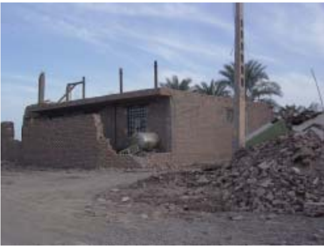
図 8 タイ付組積造とそれに接続するレンガ造の壁
