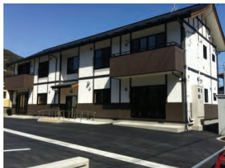
完成写真(田中東団地)
