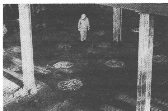
(a) 掘削表面に現れた改良体断面
