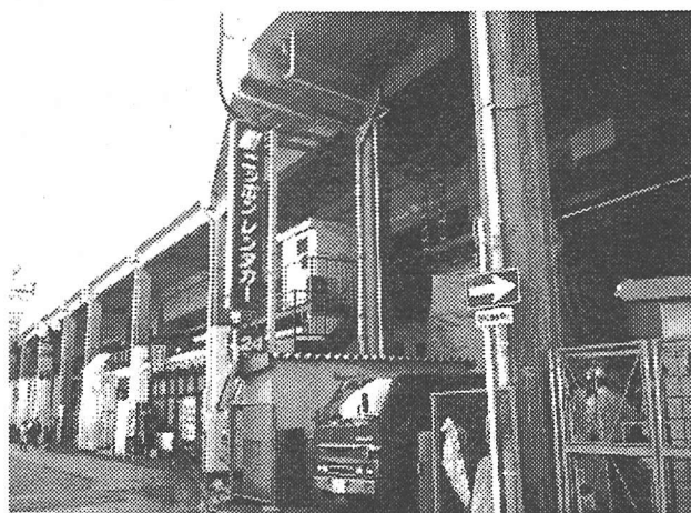
写真-1 A 高架橋の全景
