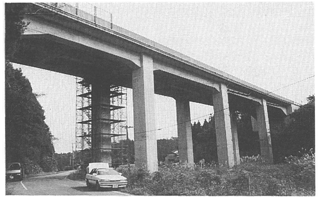
写真-1 橋梁全景
