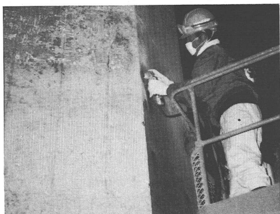
写真-2 コンクリートの表面処理
