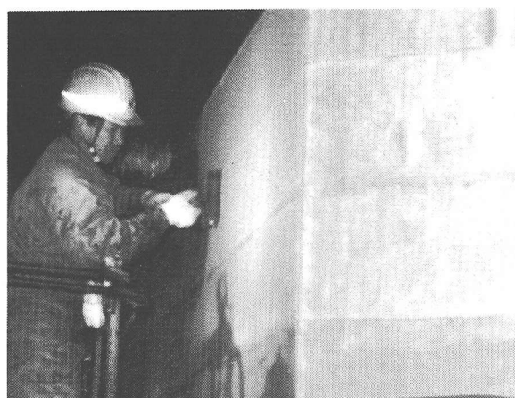
写真-4 アラミド繊維シート貼付
