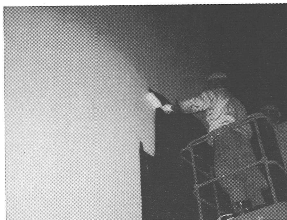
写真-5 仕上材（塗料）塗布
