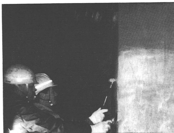
写真-3 エポキシ樹脂塗布
