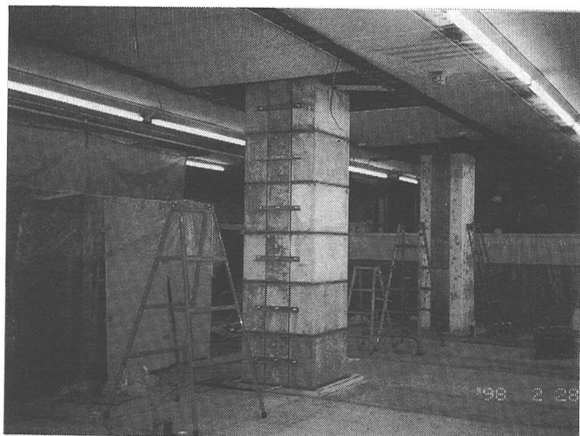
写真-5 支保工の撤去
