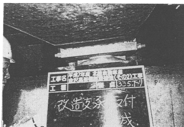
写真－2 支承改造工完了
