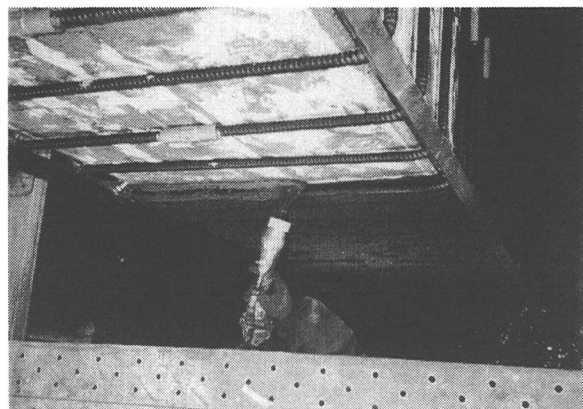
写真－９ モルタル吹付け状況（１層目）
