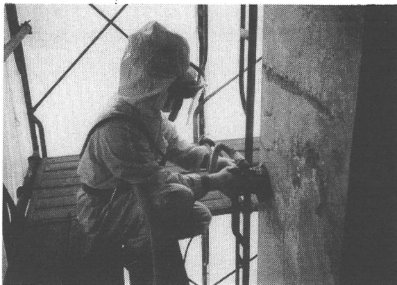
写真－ 2 表面処理状況
