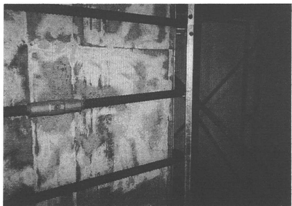
写真－７ モルタル厚さ管理用ガイド設置状況
