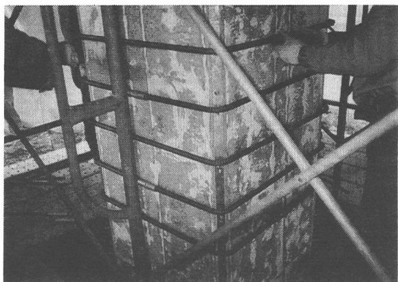
写真－４ 帯鉄筋設置状況
