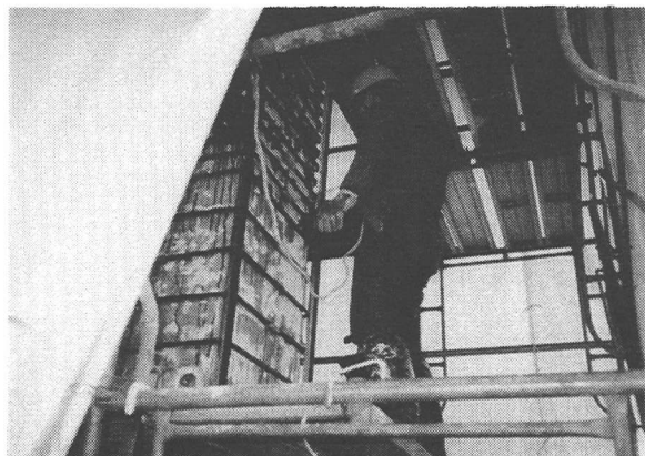
写真－８ シーラ塗布状況
