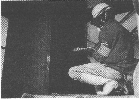
写真－１１ モルタル吹付け状況
