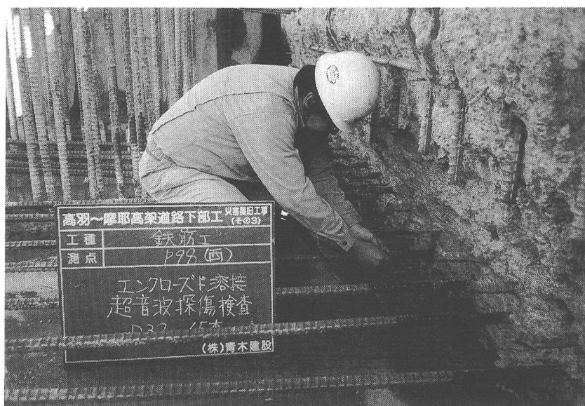
写真－５ フーチング下面鉄筋の既設鉄筋との接続（エンクローズ溶接継手）
