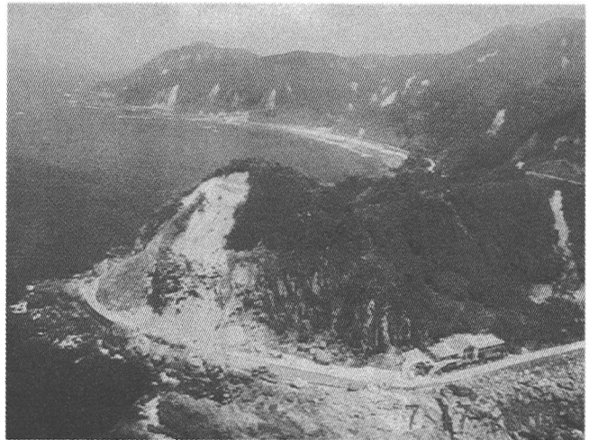
(a) 沢尻湾から長浜へ通ずる村道の斜面崩壊
