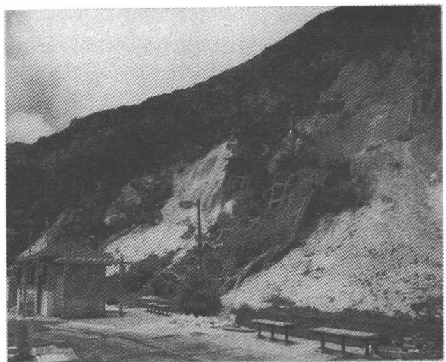
写真-2 のり砕工の崩壊 (三浦港)
